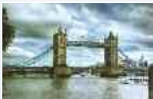
1. miesto: Tower Bridge Zájazd: Londýn (sept. 2011) - Gymn. Trenčín
